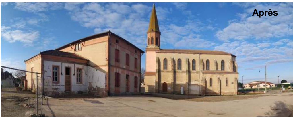
L'entreprise Bati 82 a eu en charge les travaux de désamiantage, de démolition et de déconstruction durant l'été.
