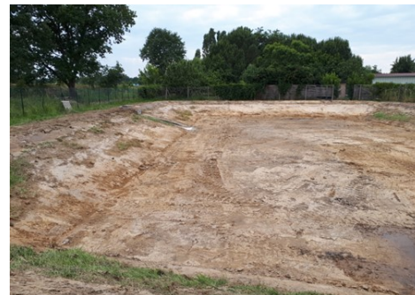
Travaux en cours, Bassin de rétention de la Nauzette
