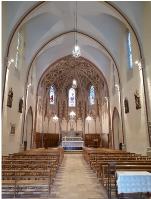
Nouvel éclairage LED de l'église
